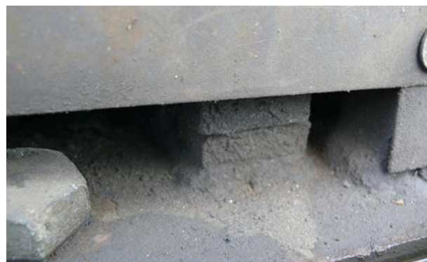
Höhenverstellung korrekt verriegelt
